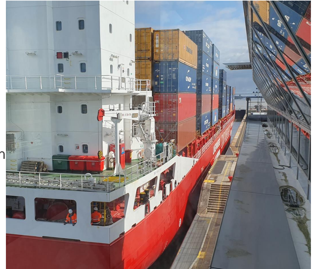
Schleusenanlage Brunsbüttel | © K. Steffen-Witt
