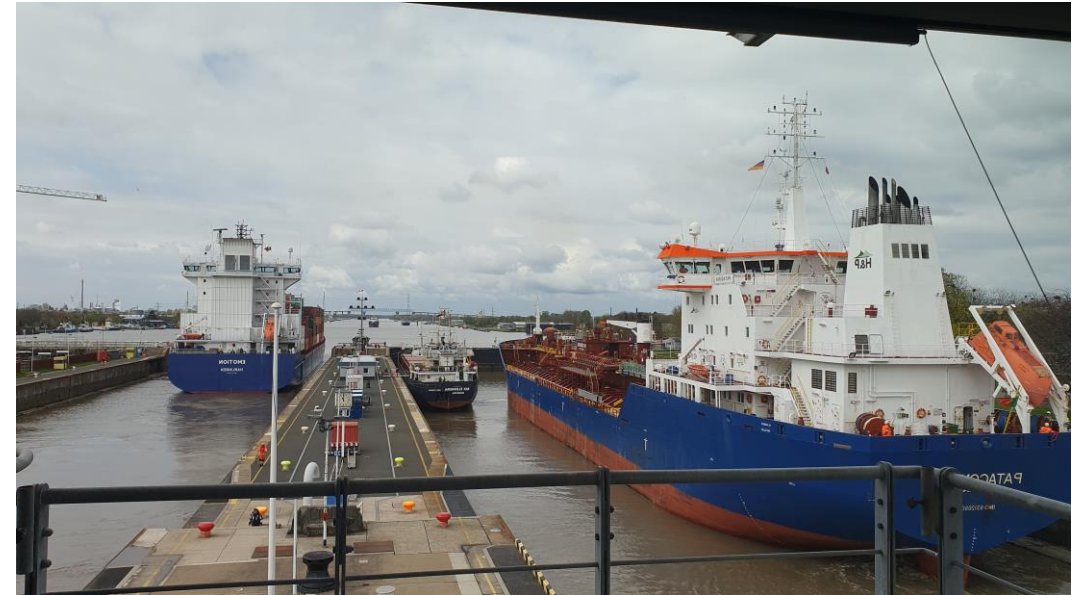
Schleusenanlage Brunsbüttel | © K. Steffen-Witt
